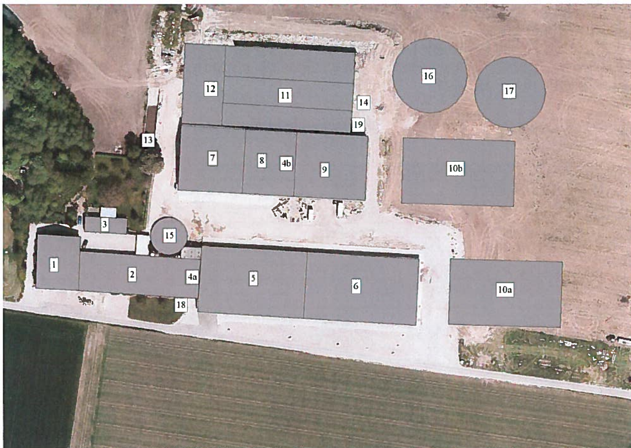
Figur 1. Oversigt over produktionsanlæggets bygninger
